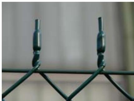
Der elektrisch überwachte Maschendrahtzaun stellt durch eine Kombination aus Durchbruchdetektion, Übersteigererkennung und mechanischer Barriere ein leistungsfähiges Peripheriesicherungssystem dar. Durch die Ruhestromüberwachung kann eine extrem geringe Quote an unerwünschten Alarmen realisiert werden. Einsätze unter Extrembedingungen ebenso wie die Anwendung in hochwertigen Privatobjekten bestätigen die Leistungsfähigkeit und die Vielseitigkeit des Systems.
