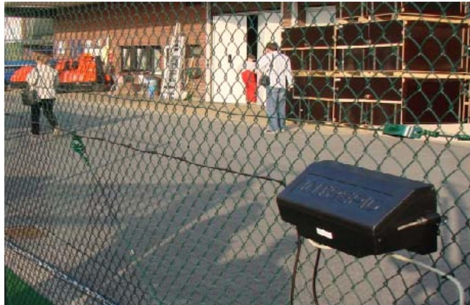
Wird ein Maschendraht- oder Gitterzaun beklettert oder aufgeschnitten, verändern die Bewegungen des Zaunes das kapazitive Feld innerhalb des digitalen Sensorenkabels. Der Angriffsort wird bis auf 3 m genau lokalisiert. Der Basiszaun muß vor der Installation nicht restauriert werden.
